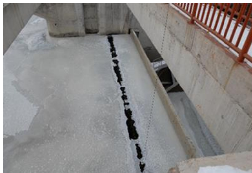
图八 表孔弧门射流防冰防冰实拍图片
