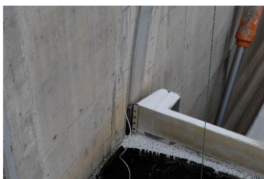
图三 气泡防冰局部效果
